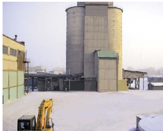
После разборки здания, декабрь 2009 года
