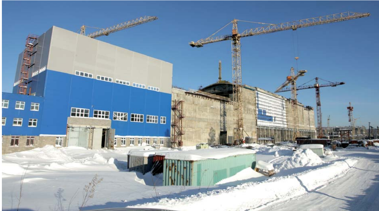
Строительство «сухого» хранилища вышло на финишную прямую
