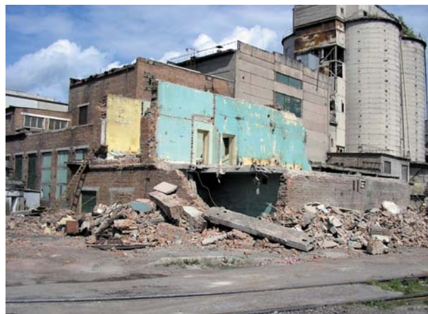
Разборка здания цеха № 10 ОАО «ХМЗ», июль 2009 года
