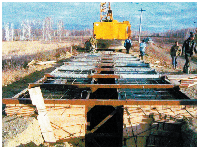
Рис. 5. Опытные работы по проходке форшахты для сооружения противofильтрационной завесы “стена в грунте” в гребневой части плотины П-11 (2005 г.)
